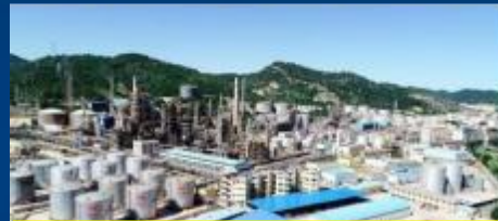
石油炼化升压厂
