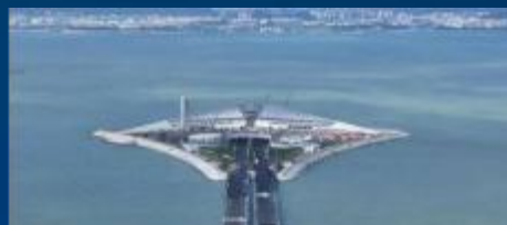
深中通道电气安全监测
