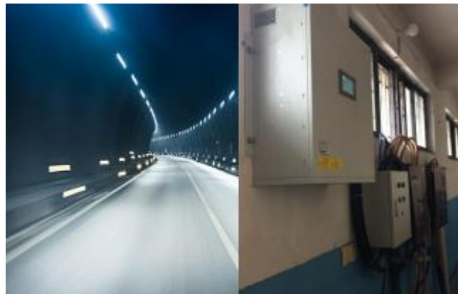
杭州绕城高速公路隧道 APF
