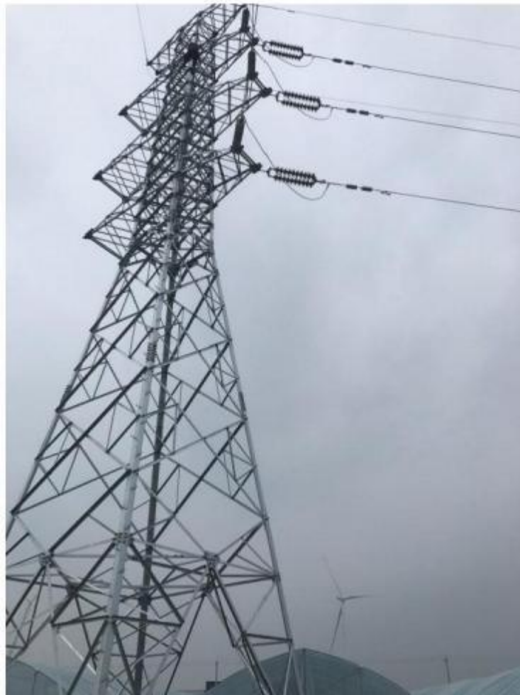
风电场35kV 架空集电线路应用
