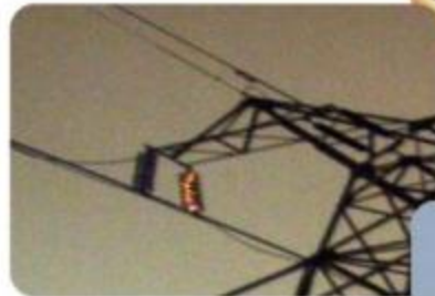
绝缘子裂化放电
