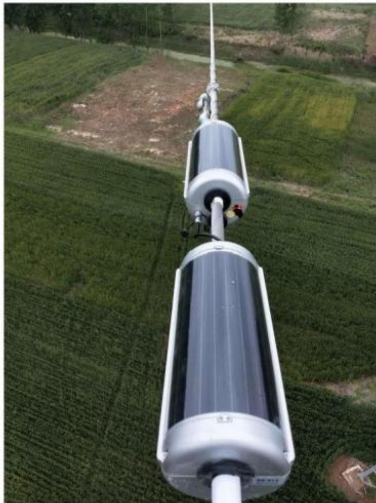
风电场35kV 架空集电线路应用
