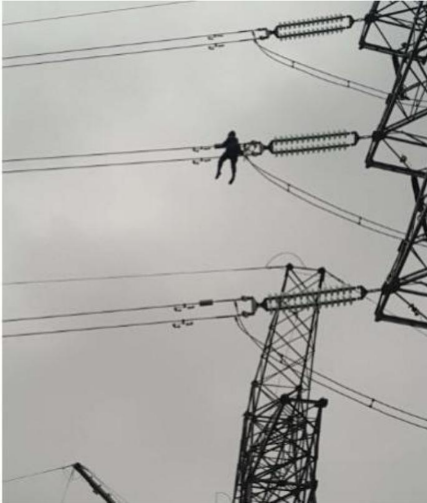
图8 故障定位装置的工程现场施工图
