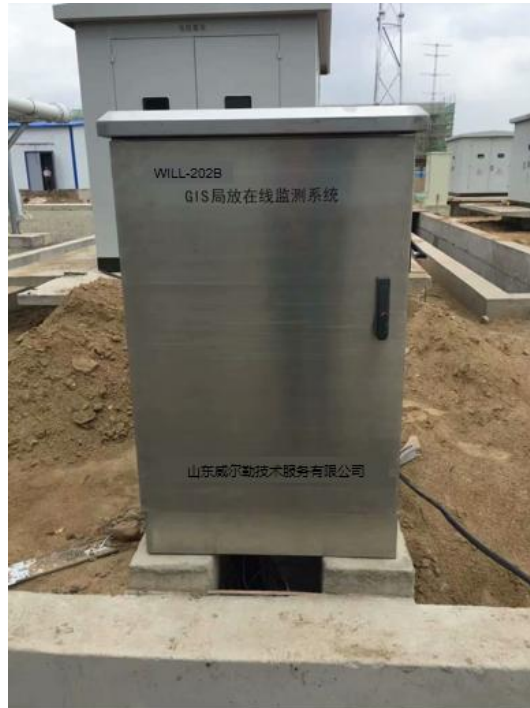
户外落地式主机监测箱安装图
