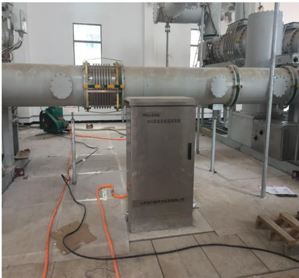
GIS 室内落地式主机监测箱安装图
